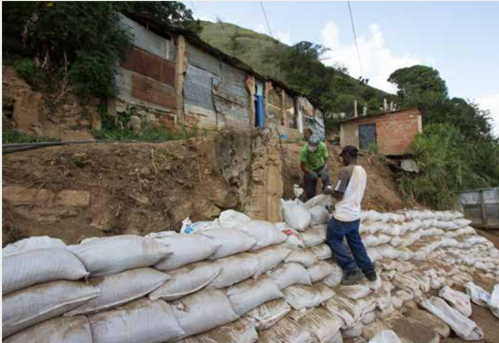
Estabilización del terreno. Fotografía: José Bastidas
