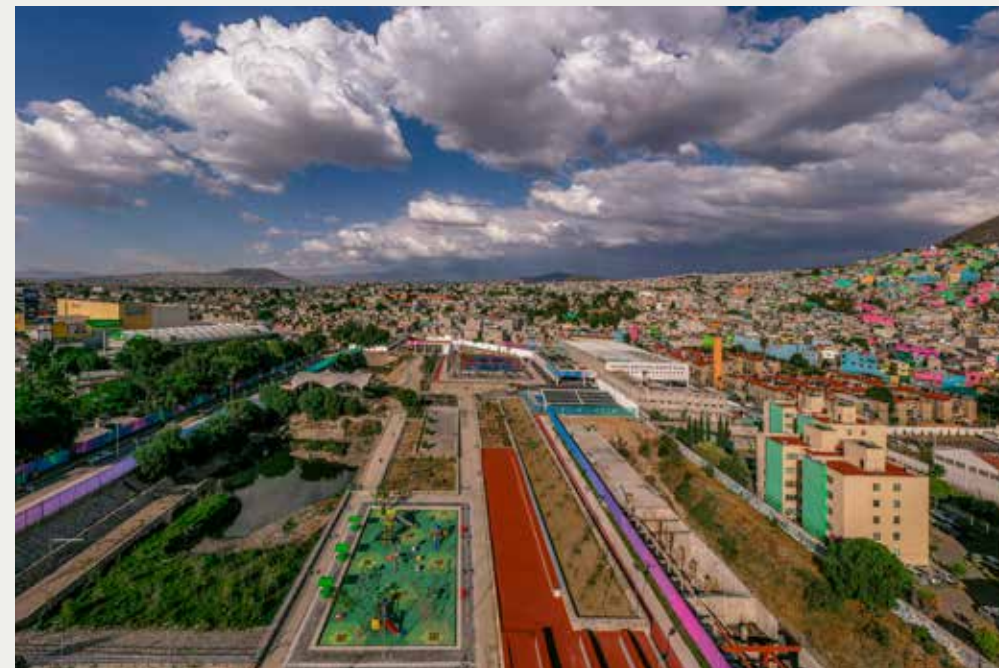
↑ Parque Hídrico Quebradora Fotografía: Aldo Díaz
