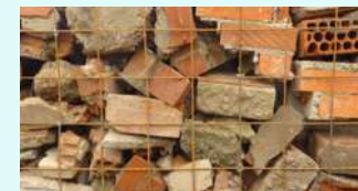
Gaviones de escombros
