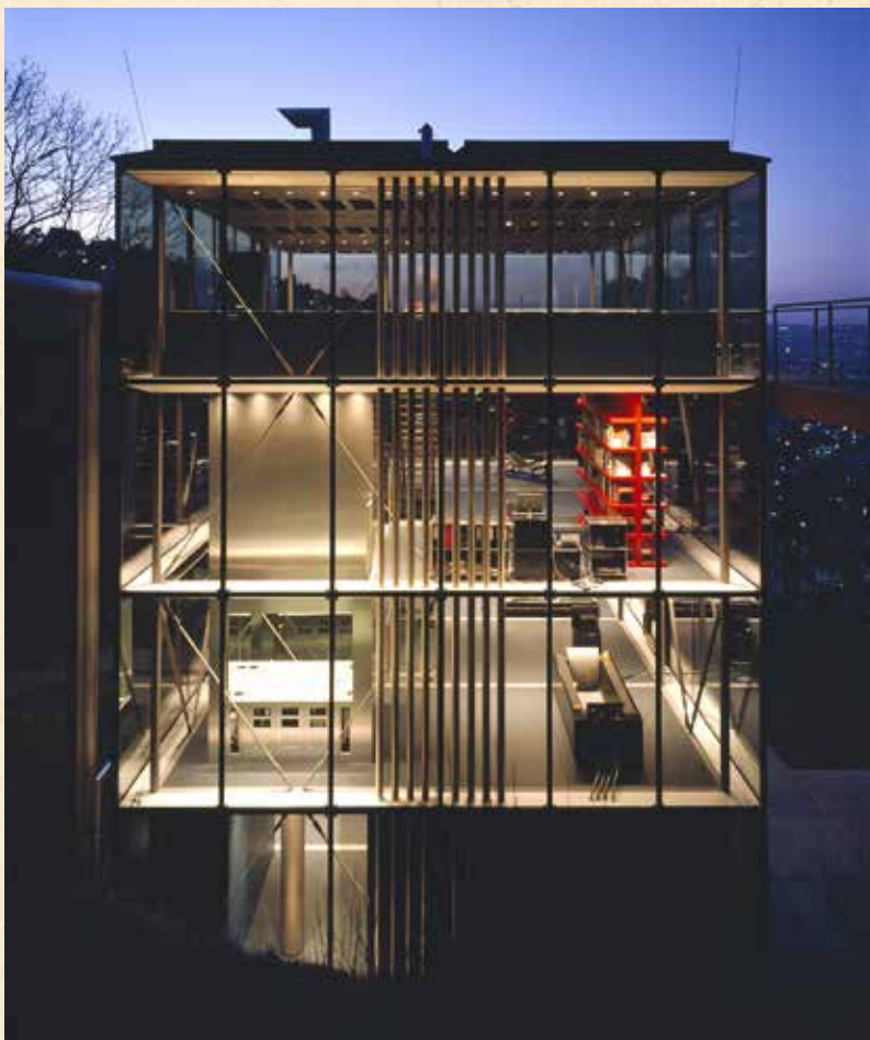
▼ La residencia R128 en Stuttgart, en Alemania, es una vivienda individual diseñada por el arquitecto alemán Werner Sobek en el año 2000. Casi totalmente reciclaje, no utiliza energía procedente de combustibles fósiles ni emite gases de efecto invernadero.
