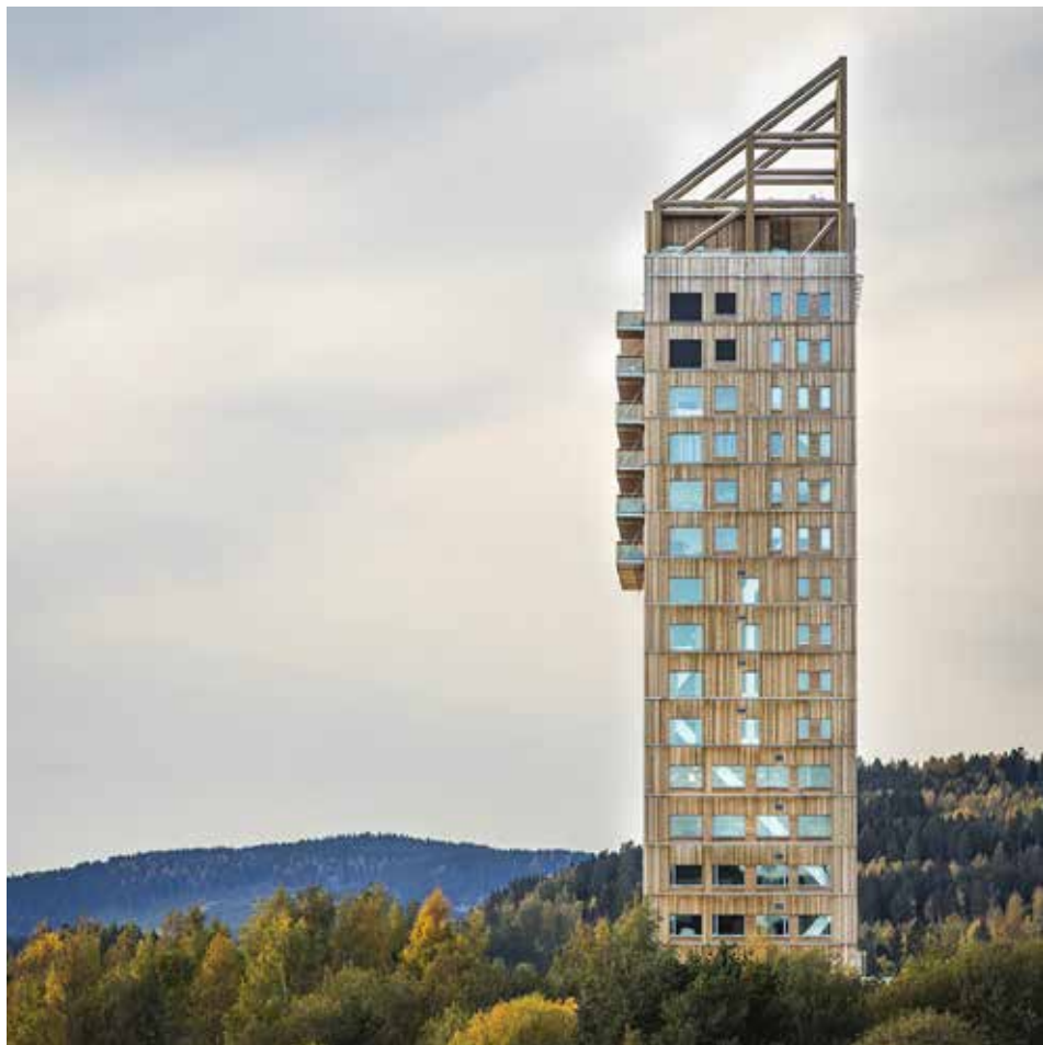
▼ Inaugurada en Brumunddal (Noruega) en 2019, Mjøstårnet (la torre del lago Mjøsa) es una de las torres de madera más altas del mundo, con más de 85 metros de altura.
