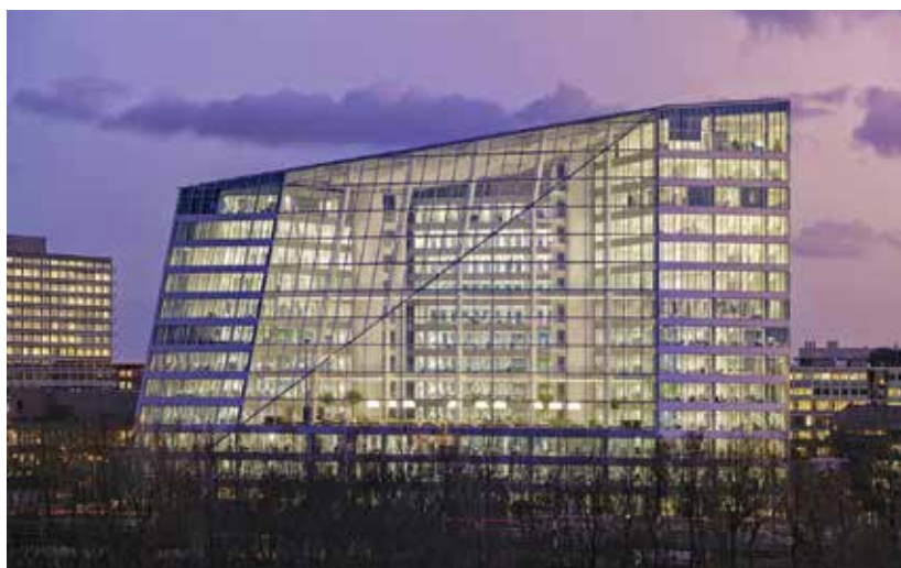
▼ Terminado en 2015, el edificio Edge en Ámsterdam, descrito como un “ordenador con un tejado”, está equipado con 28.000 captores de datos que son generados por los usuarios del edificio con el fin de optimizar la gestión y la ocupación de los espacios.
