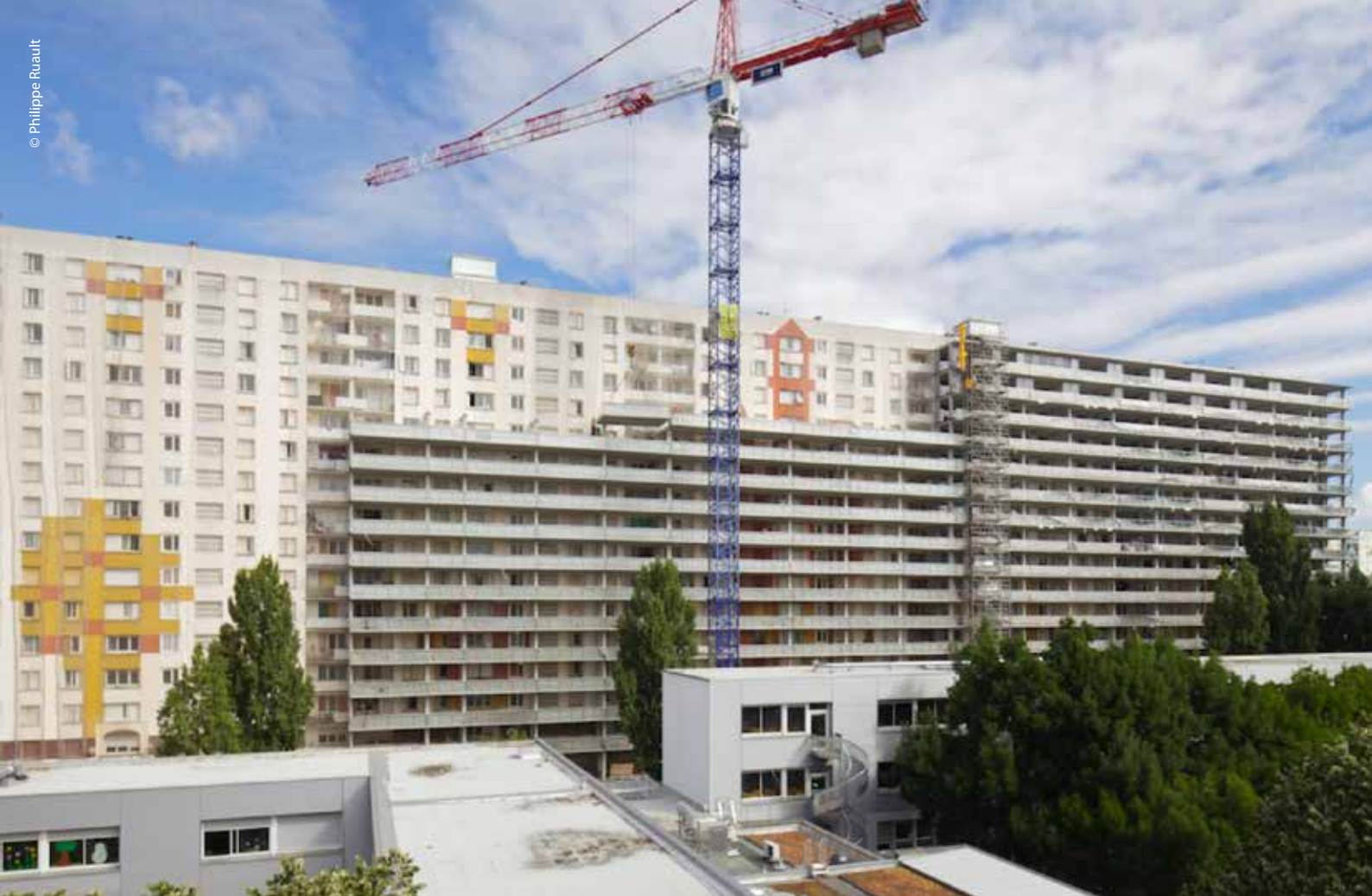
▼ Transformación de tres inmuebles en la ciudad del Grand Parc en Burdeos (Francia) por Lacaton & Vassal, Druot, Hutin en 2017. Construidos en los años 1960, estos edificios fueron metamorfoseados con la creación de jardines de invierno.
