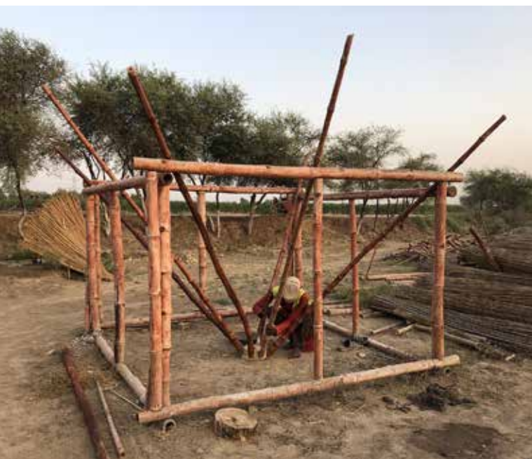
▼ Un joven artesano aprende a montar el tejado cónico de una chaunra (vivienda de una habitación), en el poblado de Bhoriyoon, en Pakistán.
